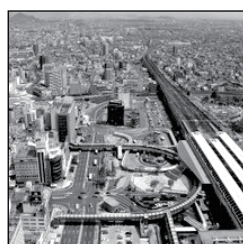
駅周辺歩行者用デッキ整備 改札が2階にある岐阜駅に合わせ整備された歩行者用デッキは問屋町再開発との連携が予定されます
